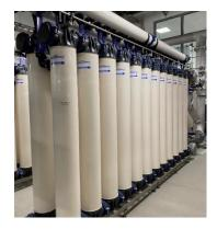
In der Ultrafiltration wird das Rohwasser durch feinste Membrane (0,02  $\mu$ m) geleitet. Diese Membrane halten alle Partikel, sowie Trübstoffe aus dem Rohwasser zurück. Zudem erfolgt in dieser Aufbereitungsstufe die zuverlässige Entfernung von Bakterien und Viren aus dem Wasser.
