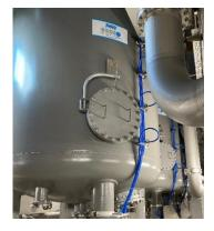
Die Aktivkohlefiltration dient als zusätzliche Schutzstufe zur Ultrafiltration. Hier werden die im Rohwasser enthaltenen Spurenstoffe, wie z.B. Pflanzenschutzmittel, deren Metaboliden, oder Medikamentenrückstände weitestgehend aus dem Trinkwasser entfernt.
