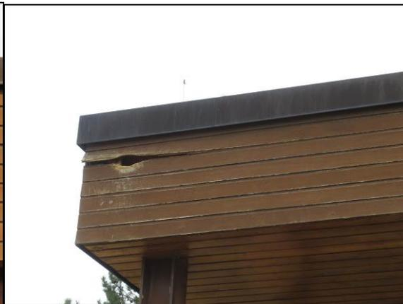
**Abbildungen 9 und 10:** Beispiel für Öffnungen/Löcher in Holzverkleidungen an Dächern im geplanten Sondergebiet.
