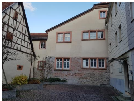
Fassadenerneuerung am Längsbau Klosterhof
