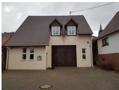
Feuerwehrgerätehaus in Impfingen
